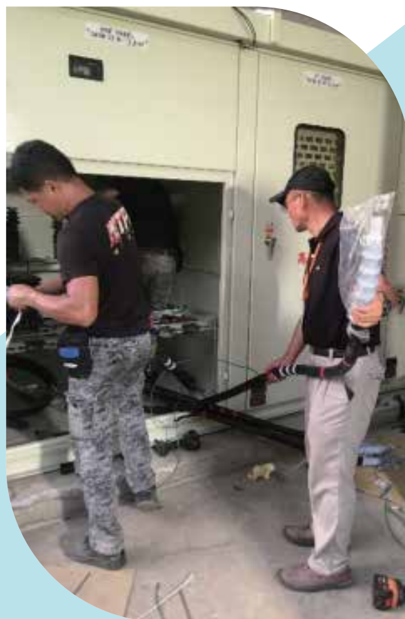
電力系統更換作業
