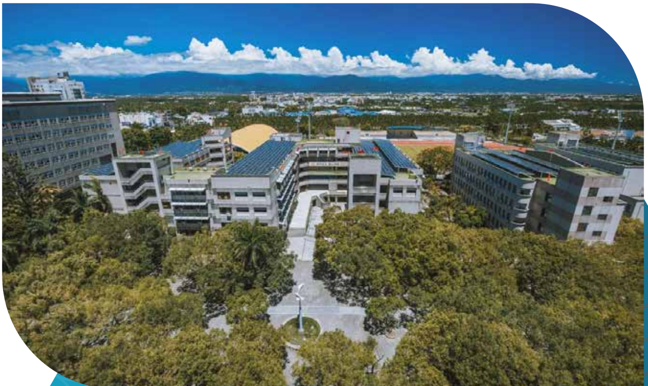
本校閒置空間設置屋頂型太陽能板
