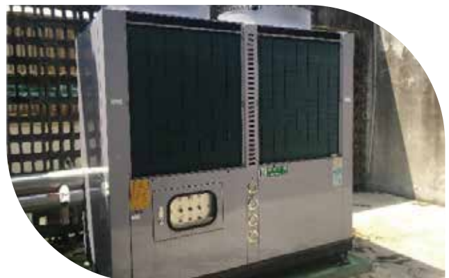
冰水主機汰換前 (左) 後 (右)
