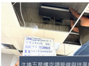
汰換五育樓空調管線與送風機
